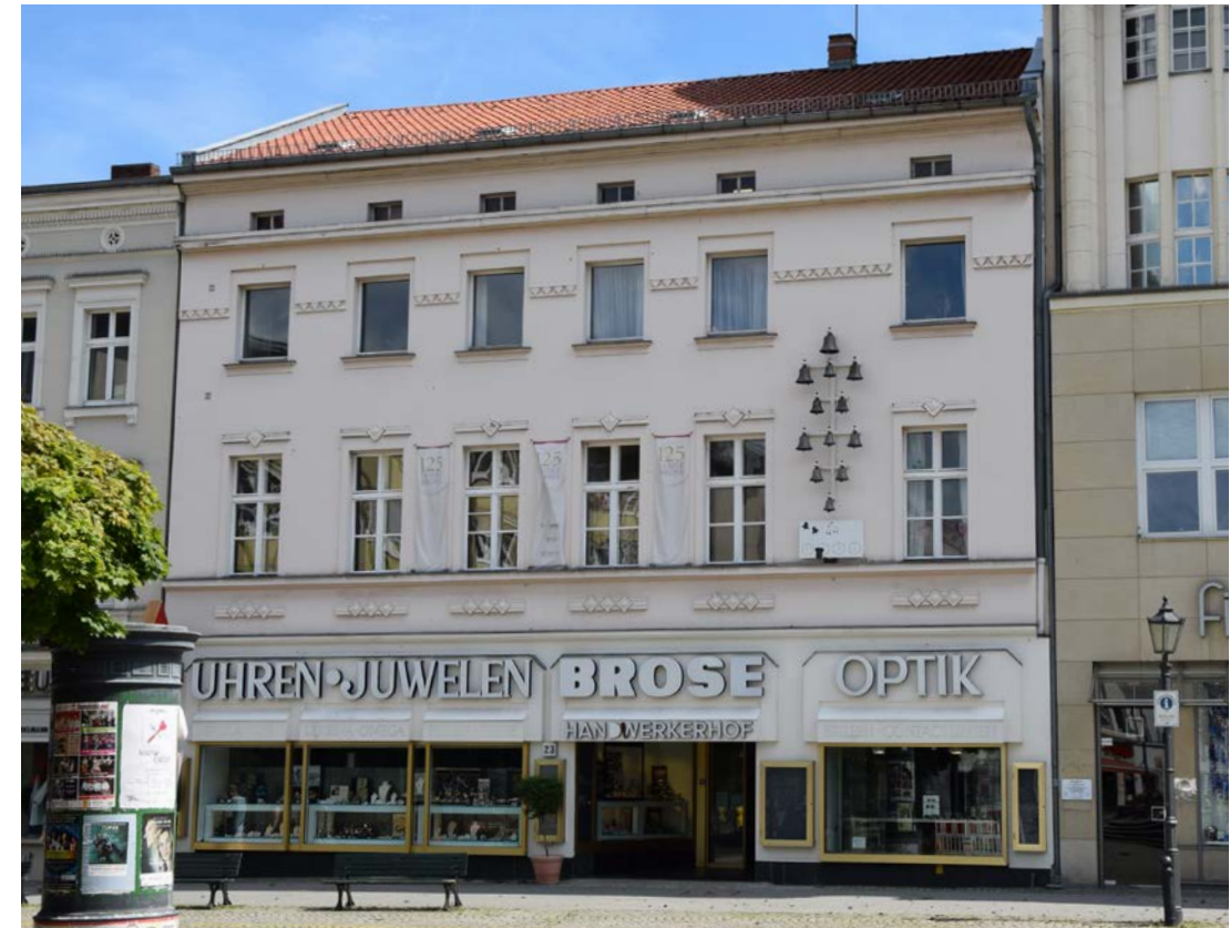
Stringent ausgerichtete Fensterachsen im Erdgeschoss und den Obergeschossen
