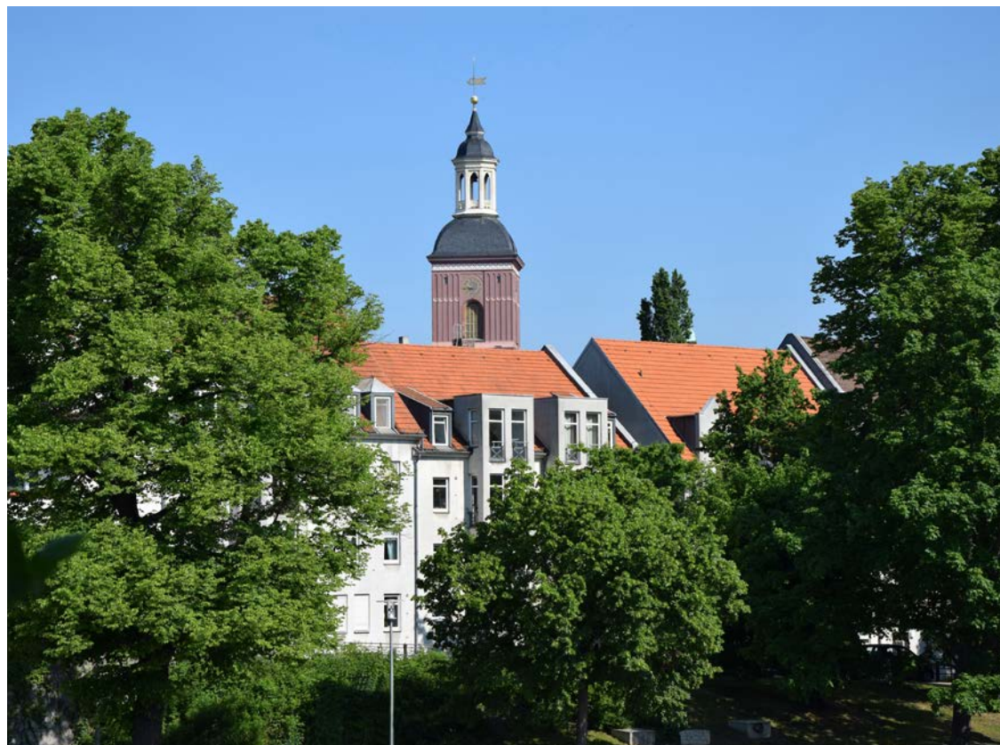
Blick über die Havel zum Turm der St. Nikolai-Kirche
