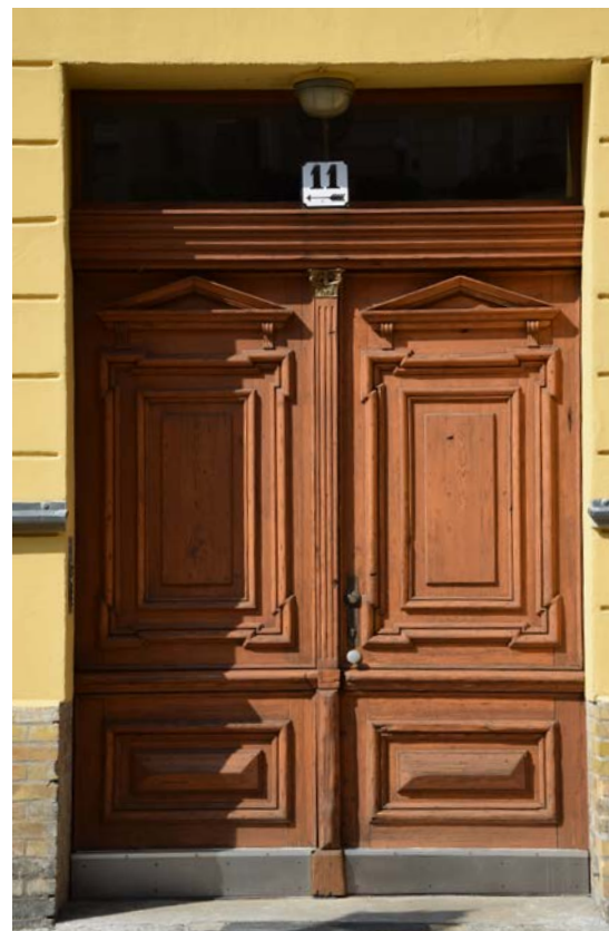
Zweiflügelige, profilierte Holztür
