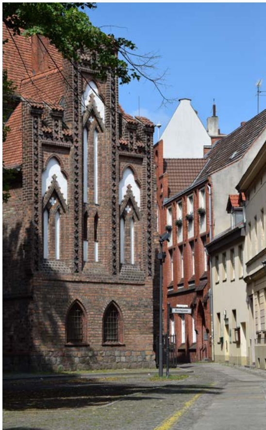
Rückfassade der gotischen Hallenkirche St. Nikolai, 14. Jh.
