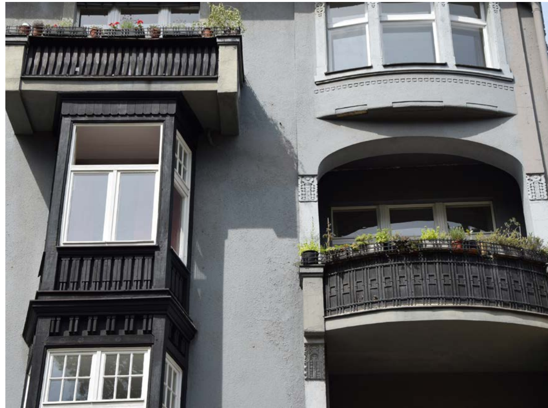
Harmonisch in die Fassade einfügende Balkone und Erker
