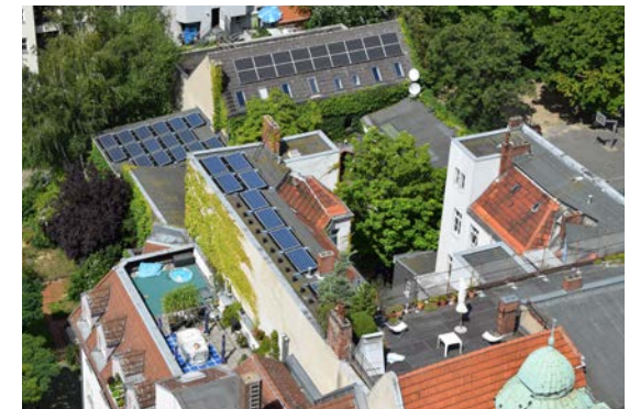
Dachlandschaft zwischen Carl-Schurz-Straße und Judenstraße
